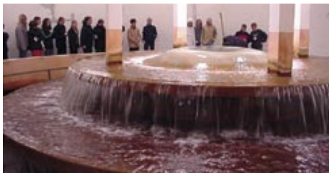
Iltningsstrappe fra Staurupværket, Århus Kommunale Værker
